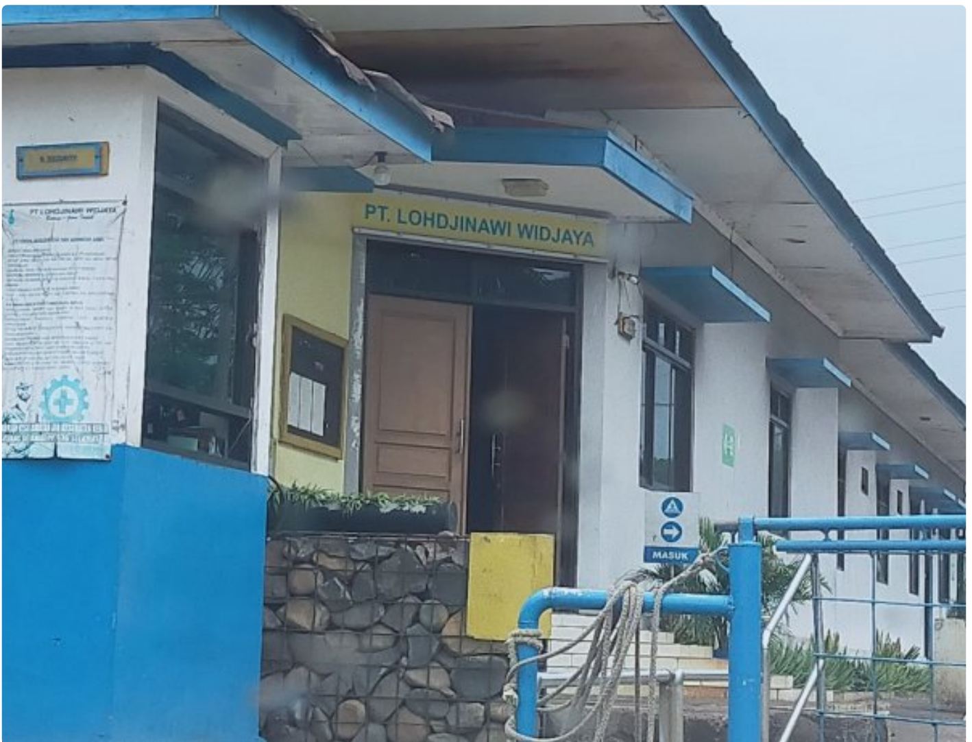
Foto Pabrik Kertas PT Lohdjinawi Wijaya Banyuputih
